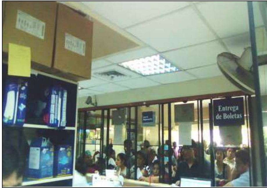
Fotografía N° 30. Los vidrios de las ventanillas de atención en Farmacia Central son crudos y no presenta lámina de seguridad.
