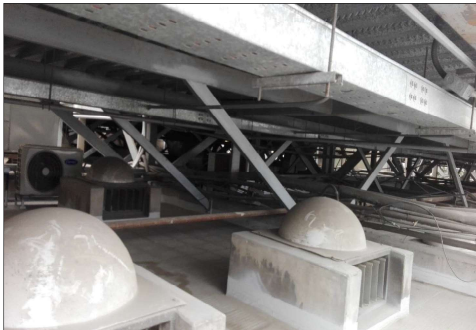
Fotografía 12. Detalle de las vigas metálicas base de la estructura que ha sufrido el reforzamiento.
