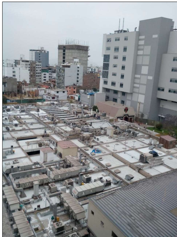
Fotografía 08. Toma general de los trabajos ejecutados en los techos.
