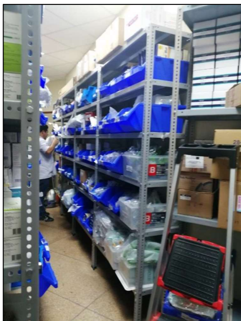
Fotografía N° 17 y 18. La estantería de Farmacia (expendio y dispensación) se encuentra fijada a la pared pero el contenido no está asegurado.
