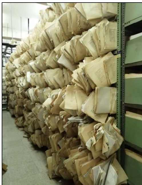
Fotografía N° 15 y 16. La estantería de Archivos de Historias Clínicas se encuentra fijada a la pared pero el contenido no está asegurado.
