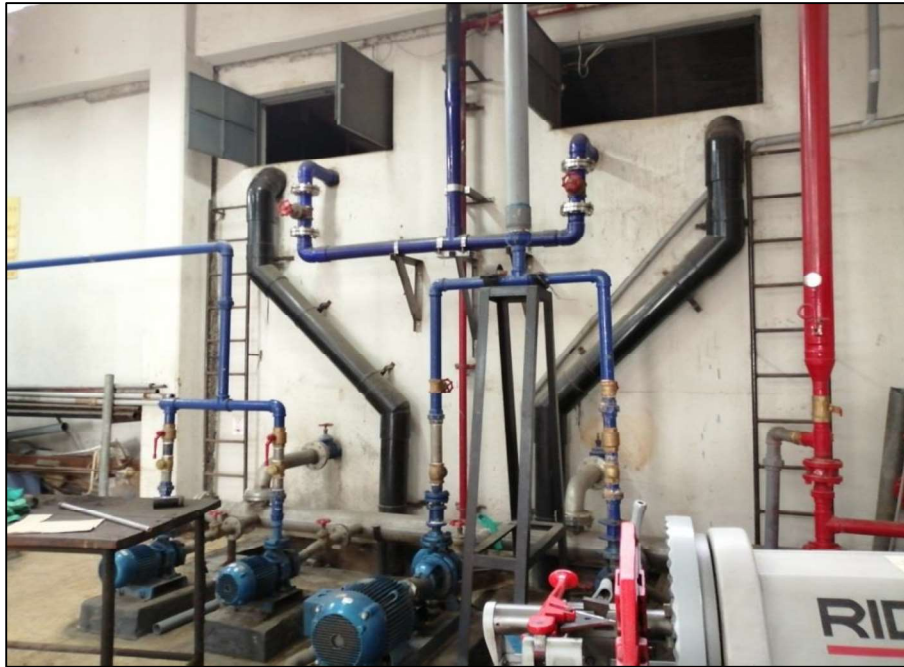
Fotografía N° 05. Vista de los tanques cisternas y árbol hidráulico.
