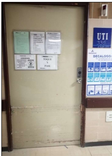
Fotografía N° 24. Puerta de ingreso en regular estado de conservación, no cuenta con protector contra impacto de camilla en UTI.
