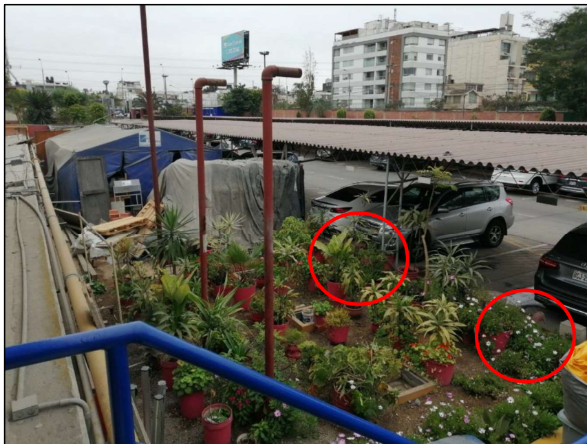
Fotografía N° 09. Se observa jardinería de la parte superior de la estructura de los tanques de combustible y el registro de toma de combustible está bloqueado por autos estacionados.
