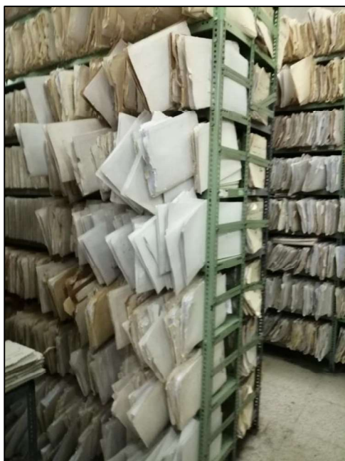
Fotografía N° 15 y 16. La estantería de Archivos de Historias Clínicas se encuentra fijada a la pared pero el contenido no está asegurado.
