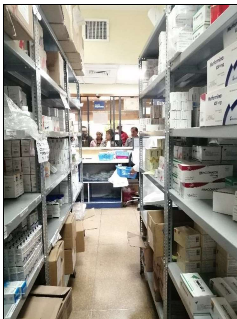
Fotografía N° 17 y 18. La estantería de Farmacia (expendio y dispensación) se encuentra fijada a la pared pero el contenido no está asegurado.
