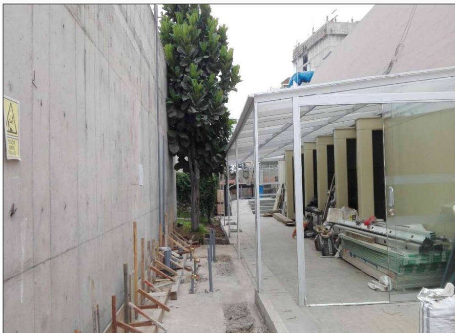
Fotografía 13. Apreciamos algunos trabajos de mejoramiento externo para el servicio de emergencia del INEN.
