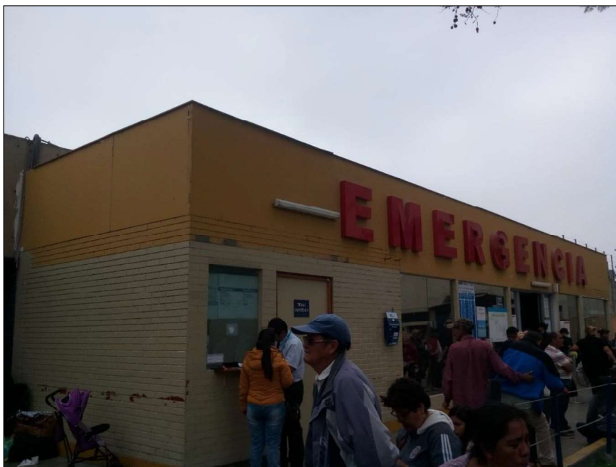
Fotografía 04. Vista de la configuración externa del área de emergencia.
