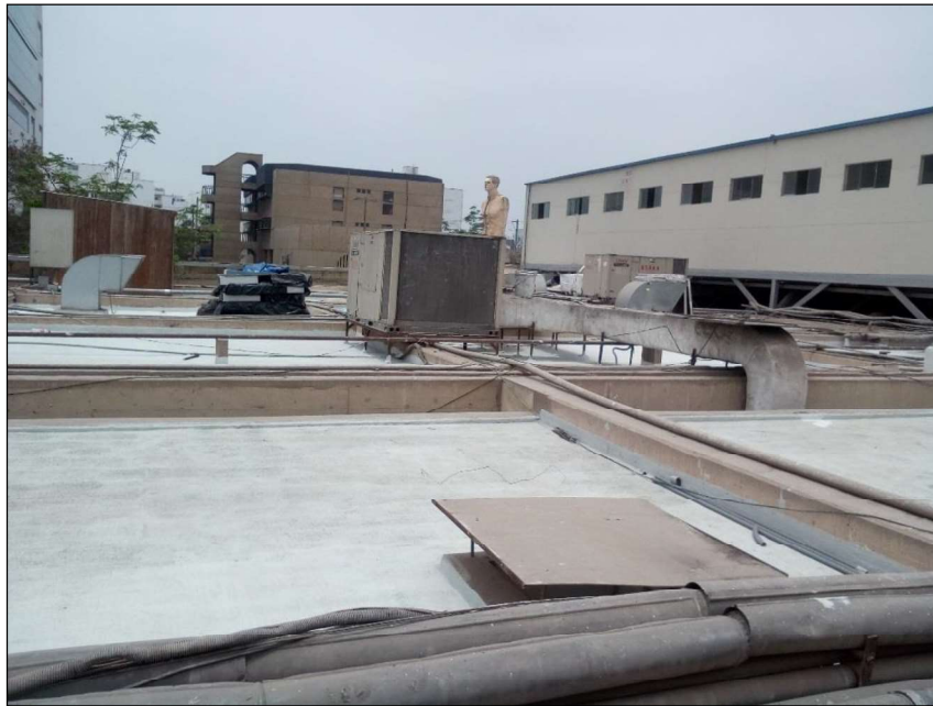
Fotografía 07. Podemos apreciar los trabajos de impermeabilización en los techos que se han venido ejecutando.
