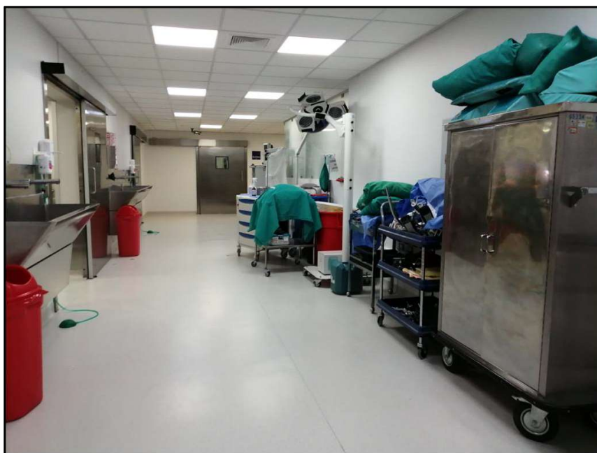
Fotografía N° 23. Los equipos móviles que no están en uso, no cuentan con seguros ni frenos que eviten su desplazamiento.
