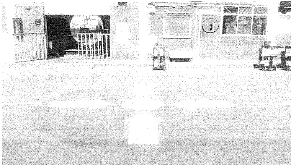
Punto de Reunión 01: Ubicado en el sótano frente a Casa de Fuerza y oficinas de OIMS
